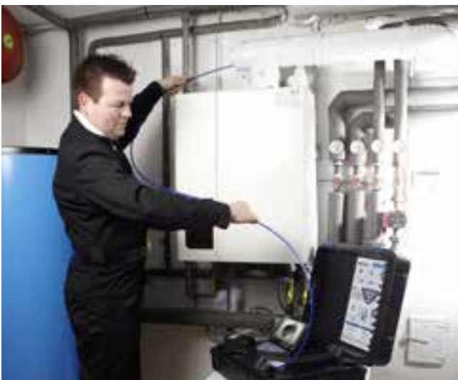
La verifica dei camini è possibile sia dal basso che dall'alto.
