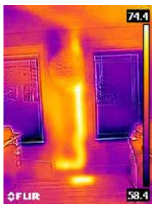
Tubo di scarico caldo nella parete
