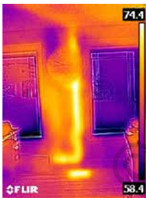
Tubo di scarico caldo nella parete
