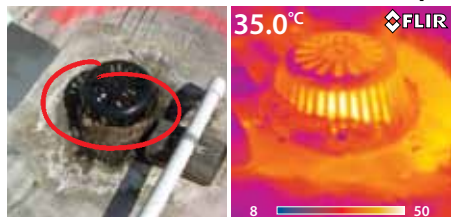
L'immagine termica mostra le infiltrazioni d'acqua nel tetto.
